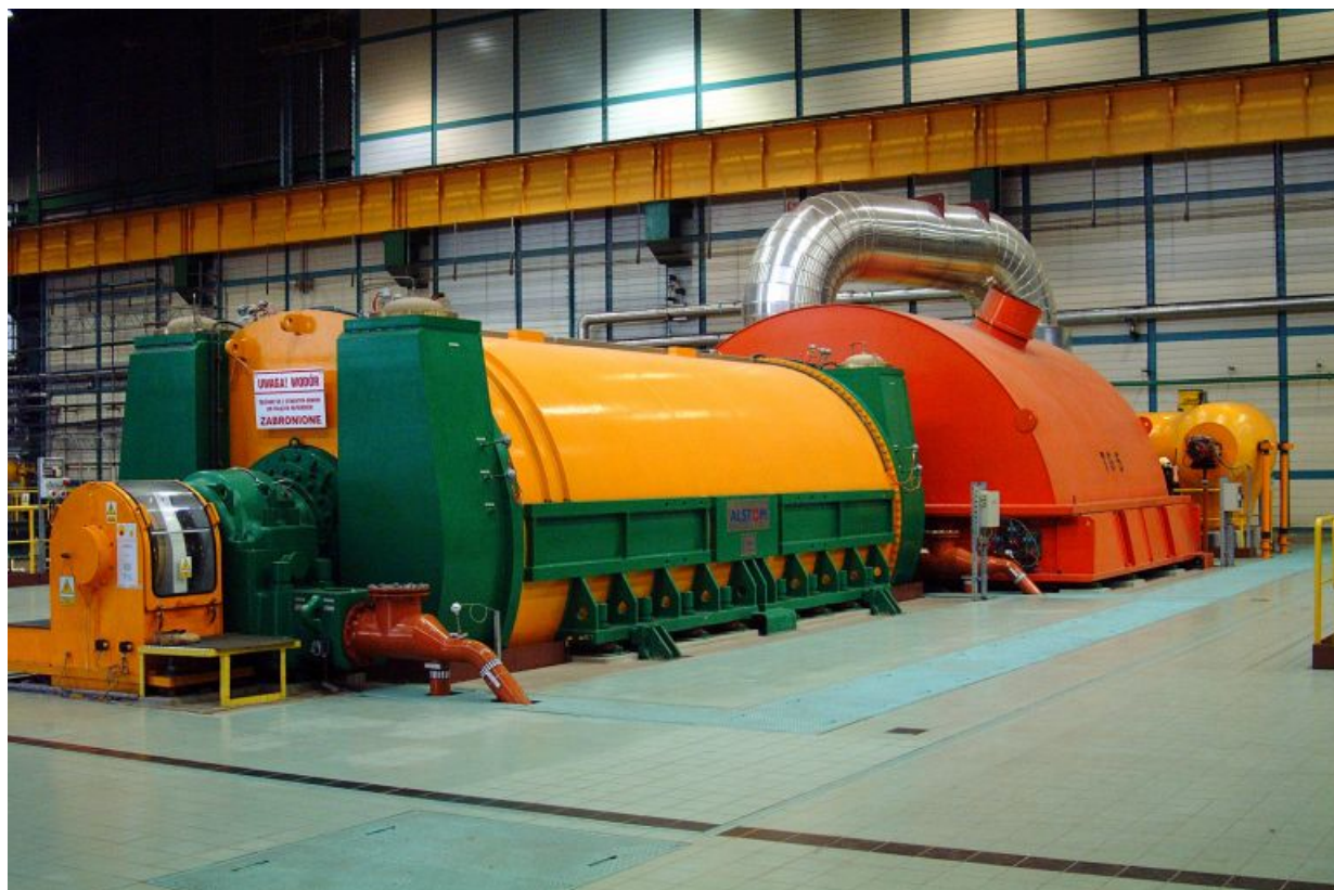
Widok generatora od strony aparatu szczotkowego
